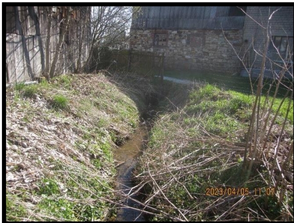
Einlauf in die Verrohrungstrecke Hasselbacher Ortsgraben
