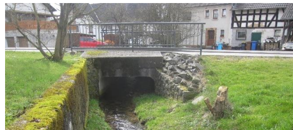
Brücke der Hauptstraße über den Werkhäuser Bach
