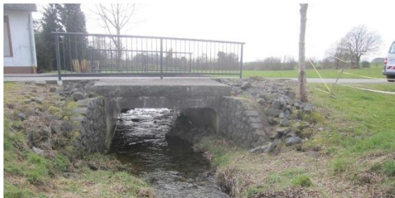
Brücke der K 24 über den Mehrbach
